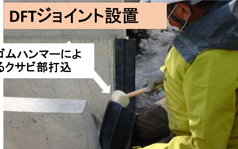
DFTジョイント打ち込み作業においても、作業効率の低下は確認されなかった。
