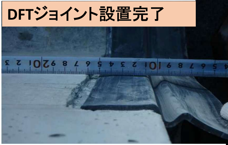
切欠部にDFTジョイントが収まり水路内部への突出は無くなった
