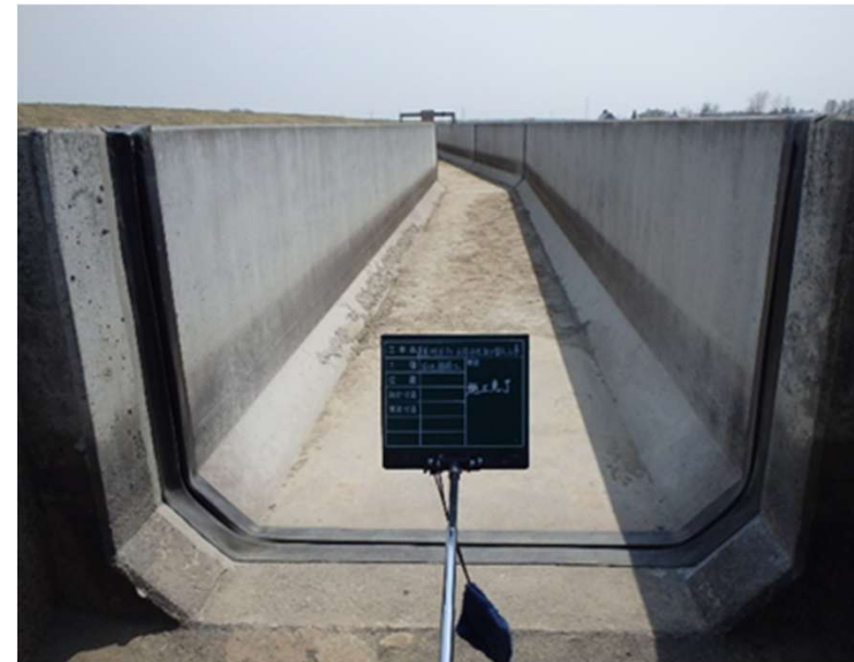
3年目DFTジョイントにて補修
