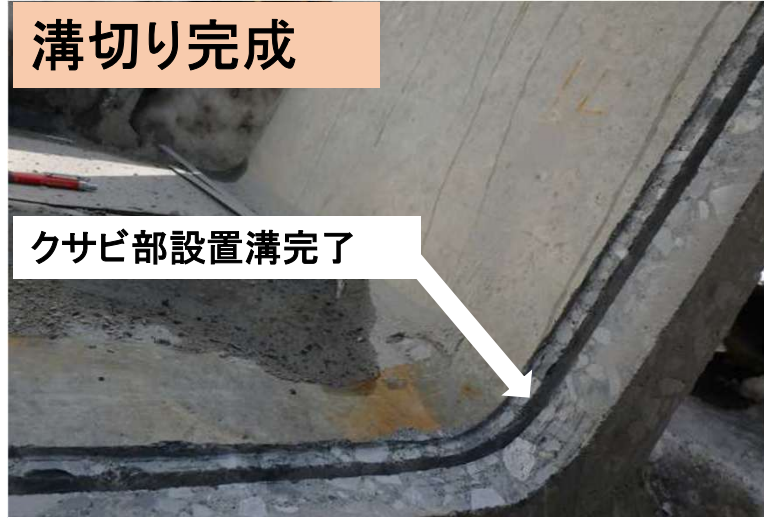
狭いスペースでも溝掘りに支障無く作業できた。
