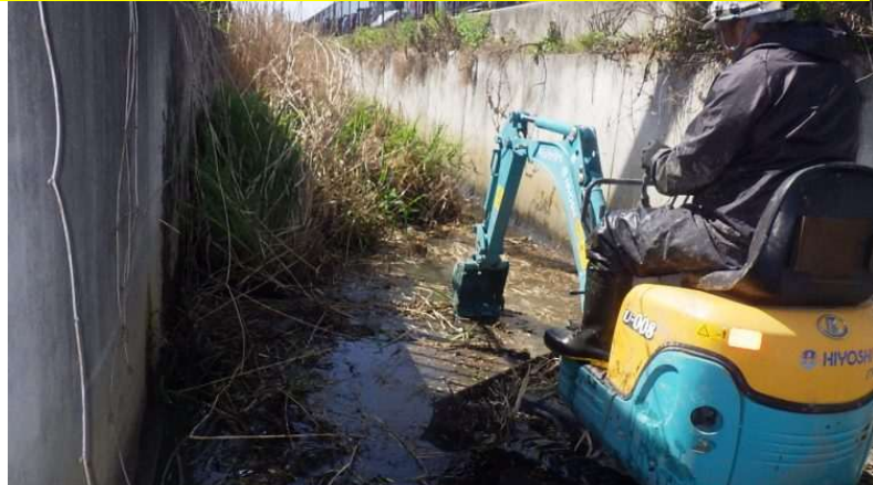
小型機械による水路土砂上げ作業
