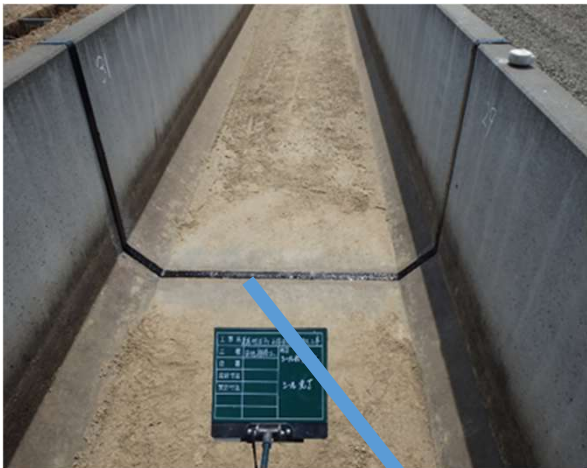
シーラ材注入工法 完了
