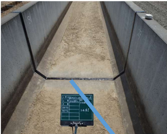
シーリング材注入工法 完了
