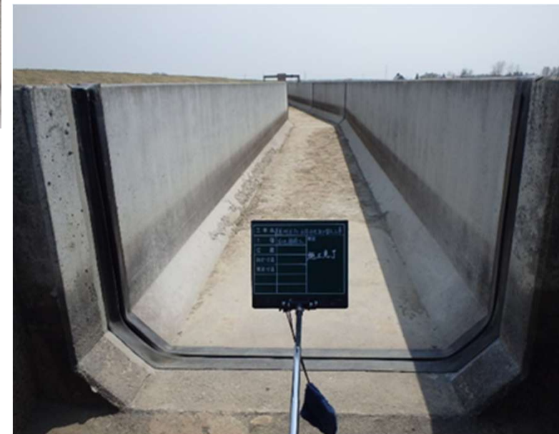
3年目DFTジョイントにて補修
