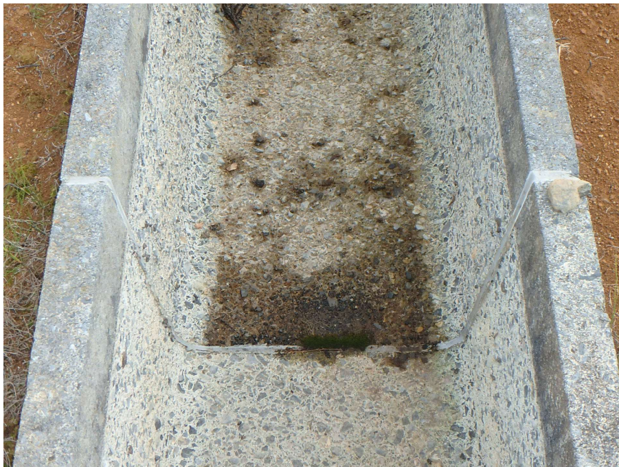
摩耗により骨材が露出水路
