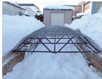
試験体設置状況（試験前）
