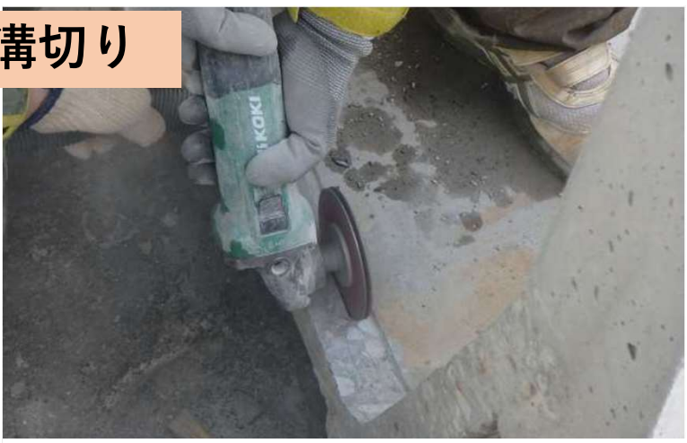
DFTカッターによる溝切りにおいて、作業効率の低下は確認されなかった。
