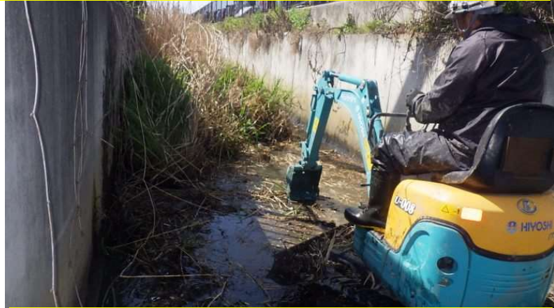
小型機械による水路土砂上げ作業
