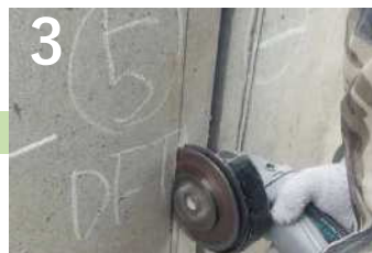
3 溝をカット 墨出しを目印に、専用開発したDFTカッターを使用し、正確にジョイント設置用の溝を設置します。
