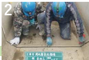
2 墨出し 使う工具は定規だけで正確に墨出しが可能。
