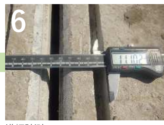
6 溝幅計測 加工した溝部を計測します。
