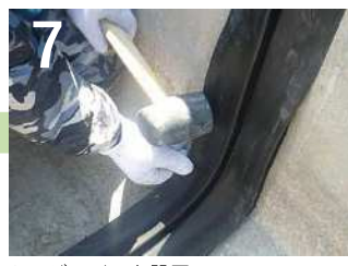
7 DFTジョイント設置 ゴムハンマーでクサビ部を溝に打ち込む簡単な施工で、水密性や引張抵抗に優れた設置が可能。
