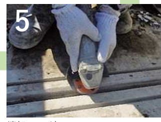
5 端部ハンチ加工 ゴムハンマーでクサビを溝に打ち込む簡単な施工で、水密性や引張抵抗に優れた設置が可能。
