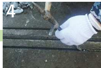
4 溝の清掃 DFTカッターで切断後、溝をはつります。
