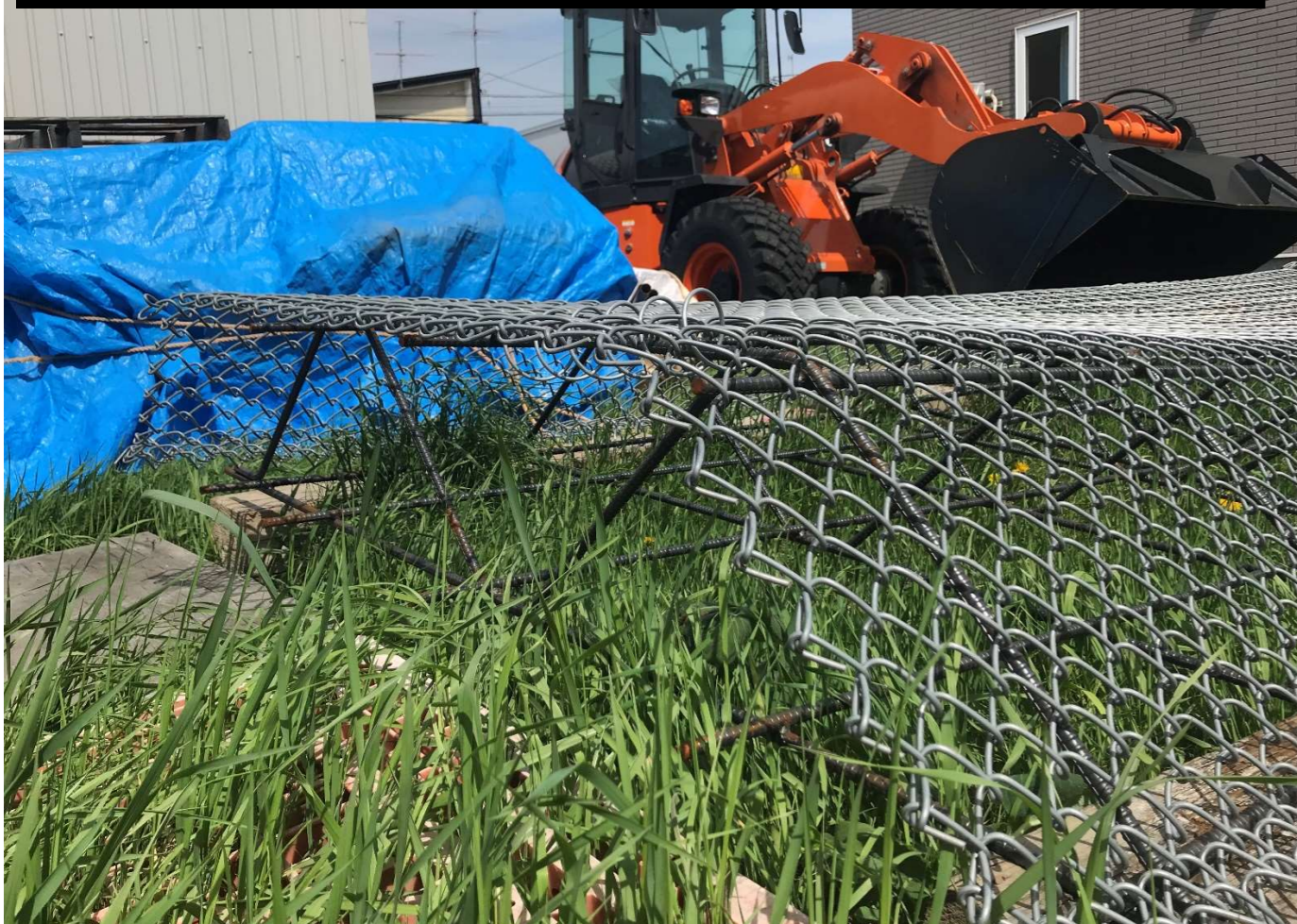
試験終了後の鉄筋D13タイプの状況、変形、沈下等は発生せず良好
