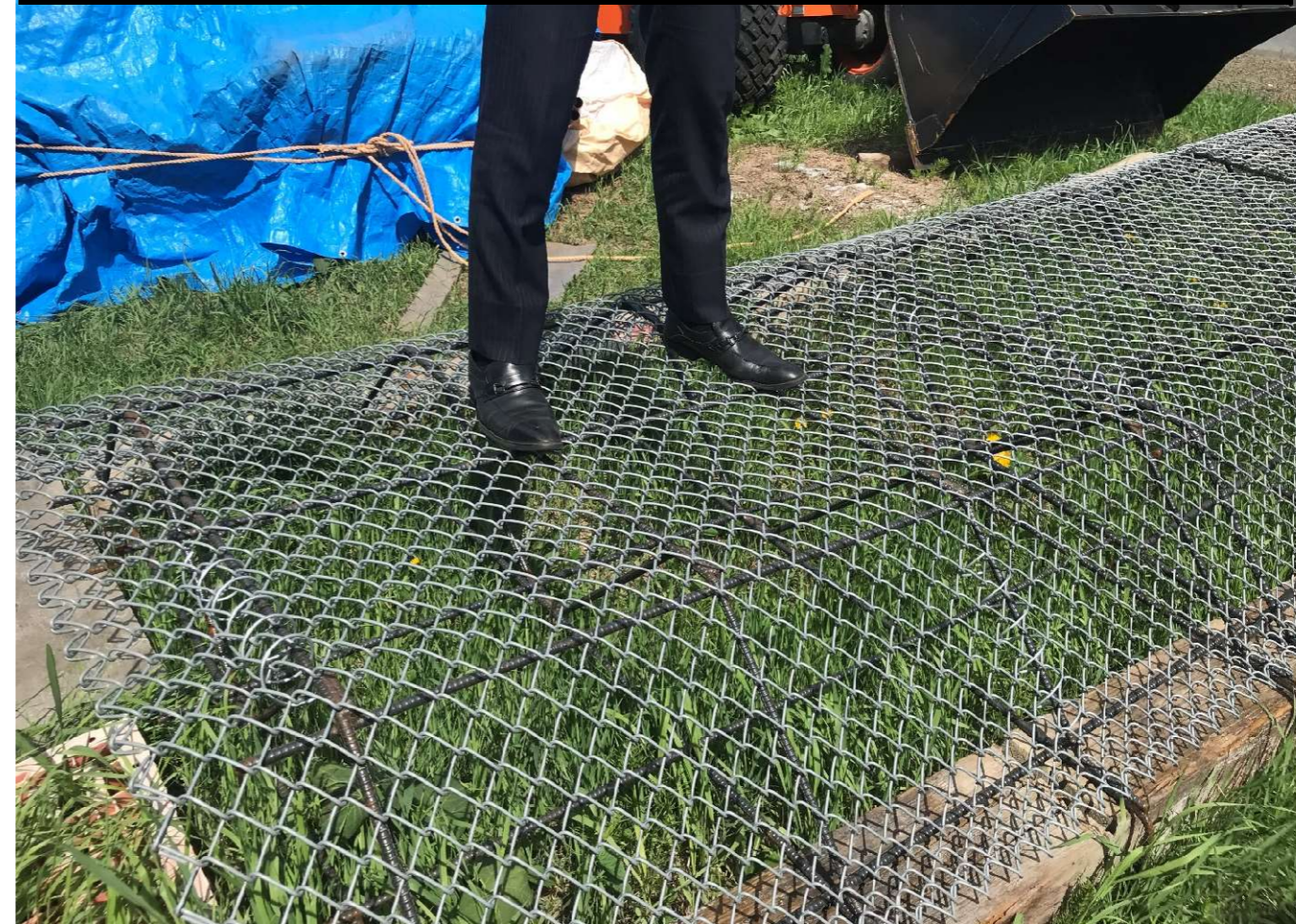
鉄筋D13タイプに75kgの方が上載しても変形、沈下等は発生せず良好
